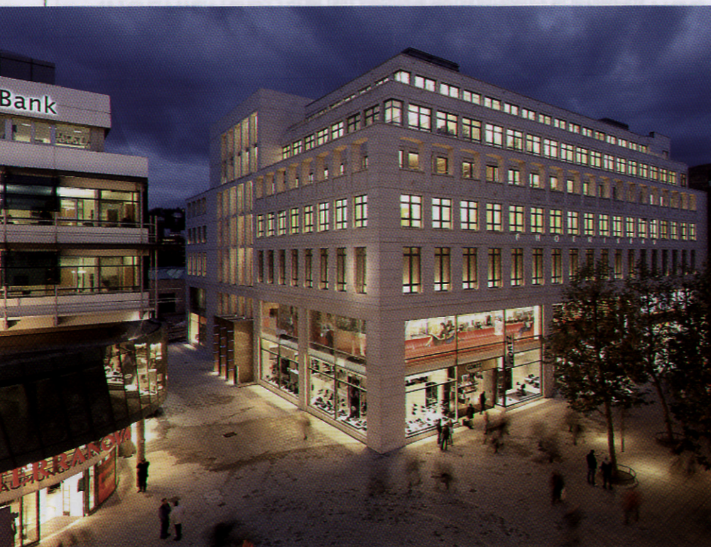
PHOENIXBAU: Mit einer markanten modernen Fassadengestaltung aus Stein und Glas fügt sich der PHOENIXBAU harmonisch, aber mit eigenständiger Architektur, in das Ensemble aus Domkirche und Königin-Olga-Bau in das städtebauliche Umfeld rund um den Schlossplatz ein Fotos (2) PHOENIXBAU: Dirk Matull
